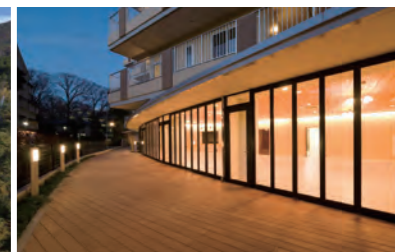
電気設備工事 | 介護施設
