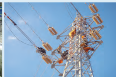
送電工事 | 架空送電線
