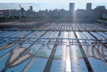
社会インフラ工事 | 浄水場
