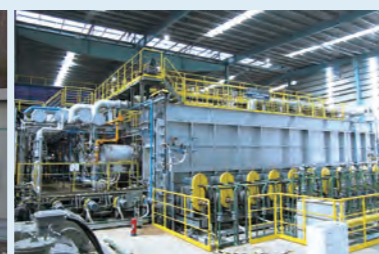
産業システム工事 | 製鐵工場
