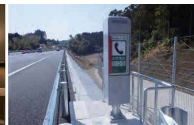
情報通信工事 | 非常電話設置
