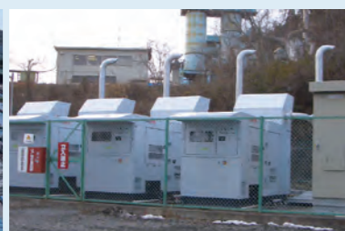
発電設備工事 | 非常用電源設置
