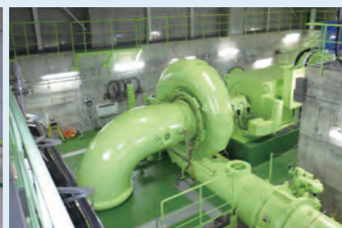
発電設備工事 | 小水力発電設備
