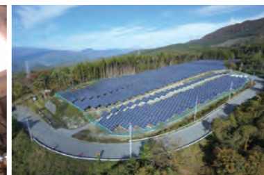
内線工事 | 太陽光発電設備
